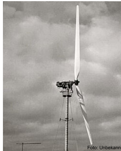
1949: 10 kW-Anlage Allgaier Werke
