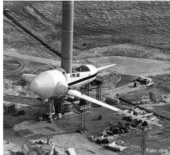
1983: Growian: 3 MW, 100 m Nabenhöhe, 100 m Rotordurchmesser
