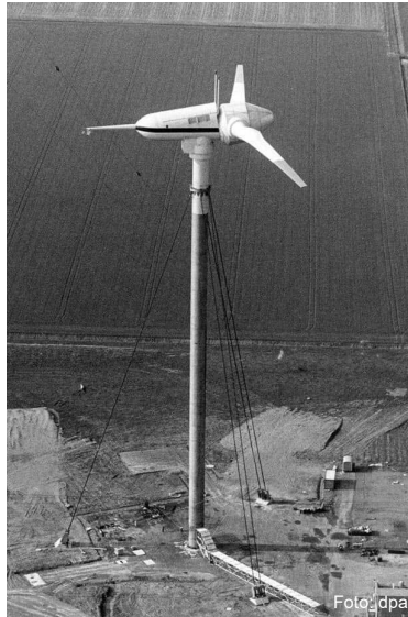
1983: Growian: 3 MW, 100 m Nabenhöhe, 100 m Rotordurchmesser
