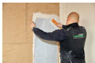
...Innendämmung mit Wandheizung
