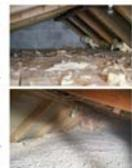
Abbildung 1: Dämmung der obersten Geschossdecke mit Kernwolle aus Glaswolle (links) und mit Zellulosefasern (rechts).
